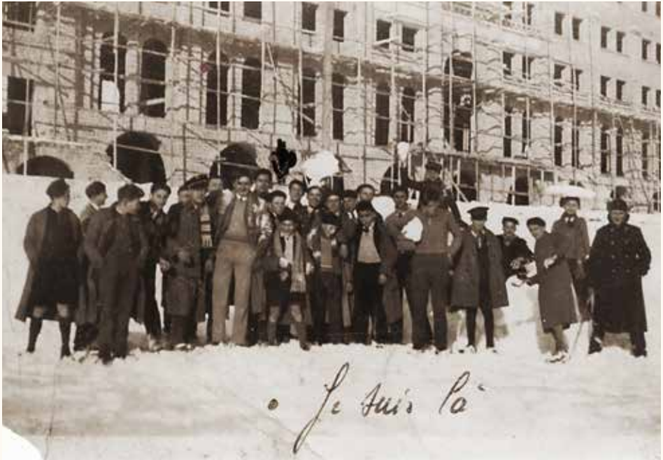
Photo de classe de la première promotion en 1933. Les échafaudages sont encore en place.
