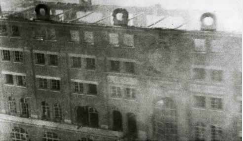
L'école après l'incendie. La toiture encore fumante.
