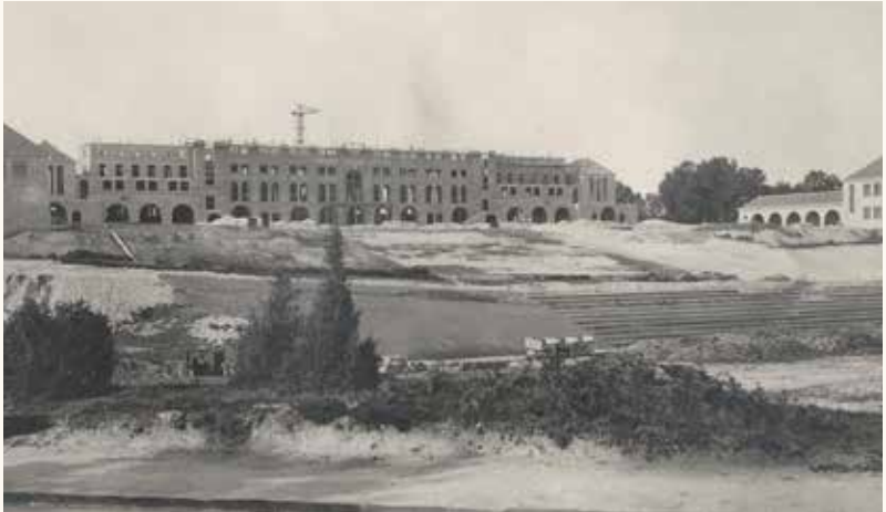
L'école en construction.
