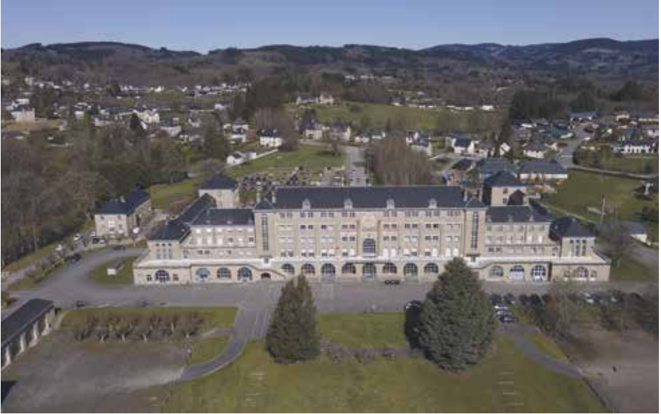
Vue du bâtiment principal depuis le sud.
