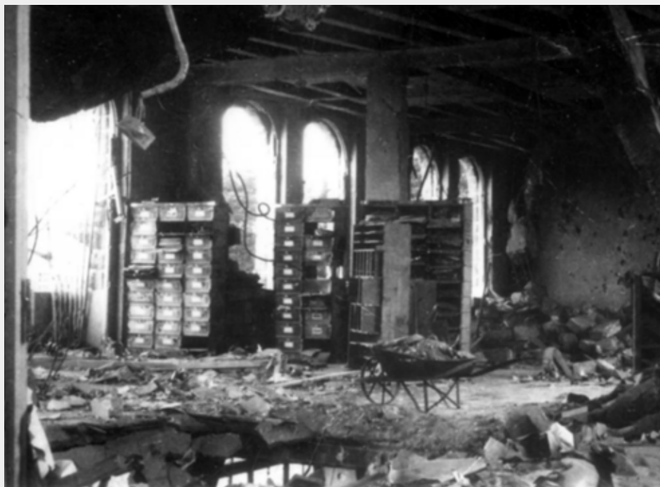
L'intérieur du bâtiment principal dévasté.
