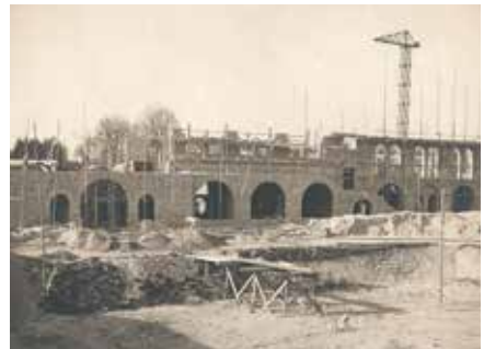
L'école en construction.
