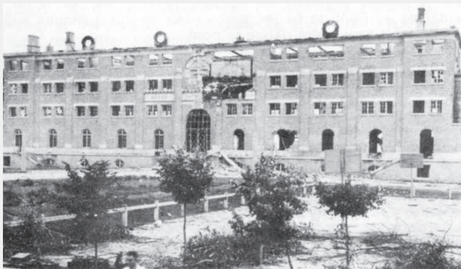
Le bâtiment principal après les combats d'août 1944.
