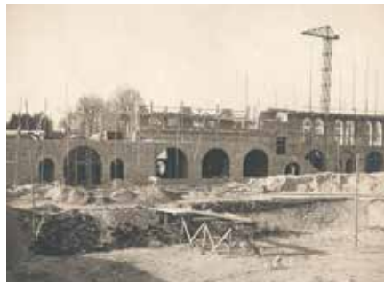
L'école en construction.
