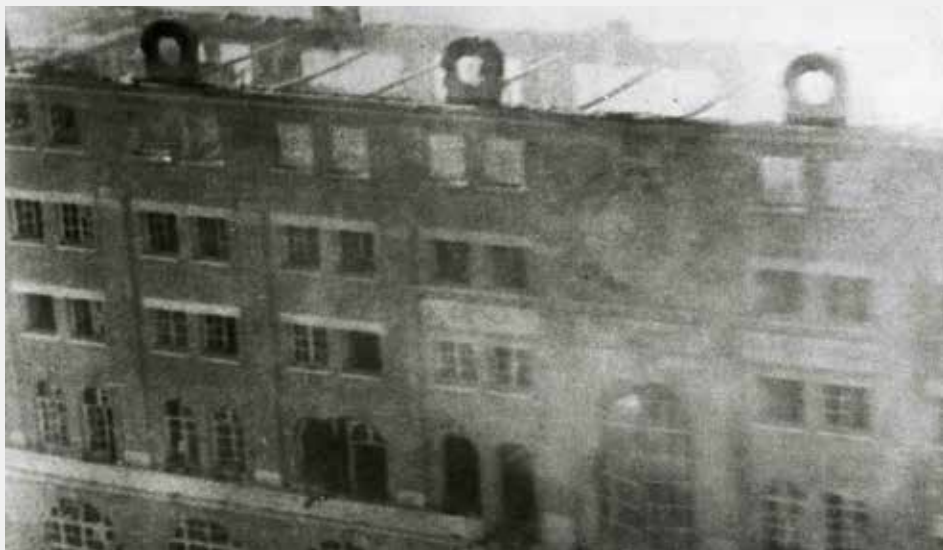
L'école après l'incendie. La toiture encore fumante.
