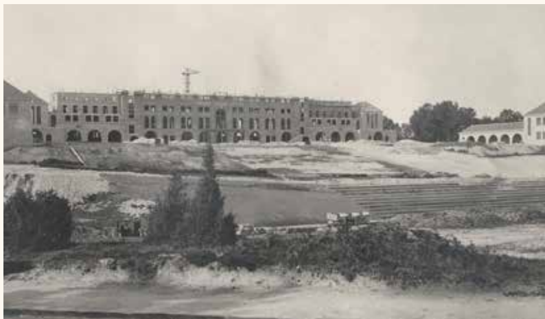
L'école en construction.
