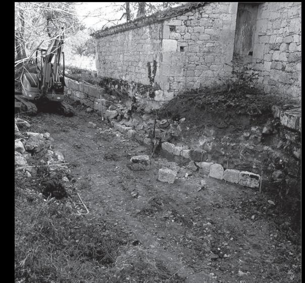
En 2015, le propriétaire a souhaité assurer la restauration des murs de soutènement du bief d'amenée et des vannes afin de garantir le passage de l'eau et le fonctionnement du rouet. L'opération a été menée conformément aux prescriptions techniques proposées par les services de l'Etat, du CAUE47, du Département et de la Fondation du Patrimoine.
