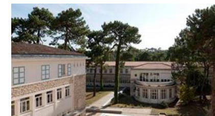
Lycée Grand Air d'Arcachon ©Région Nouvelle-Aquitaine
